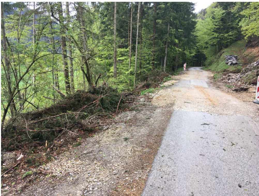
Slika 9: Pogled na plaz
