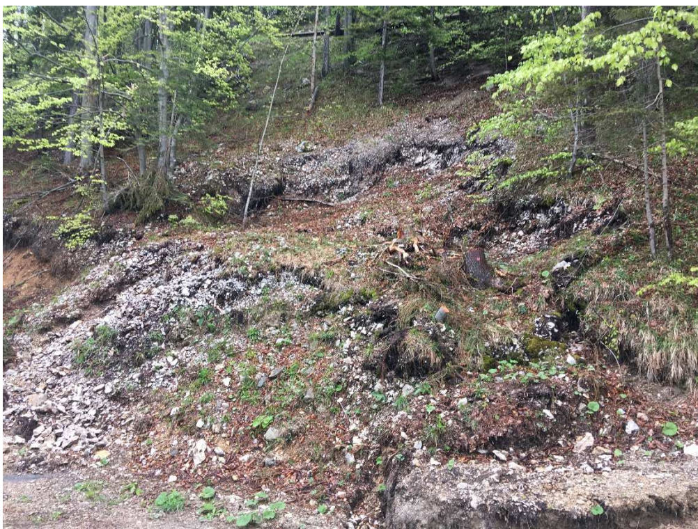
Slika 10: Pogled na plaz
